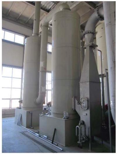
**Función:** Depuradores compuestos de una o más torres para eliminar los componentes volátiles orgánicos en los efluentes procedentes de los típicos procesos de Rendering
